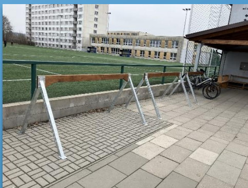
Výroba a instalace stojanů na kola / březen 2025
