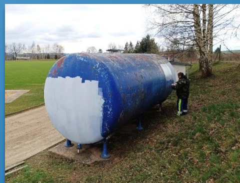
Údržba nádrže zavlažovacího systému / duben 2025
