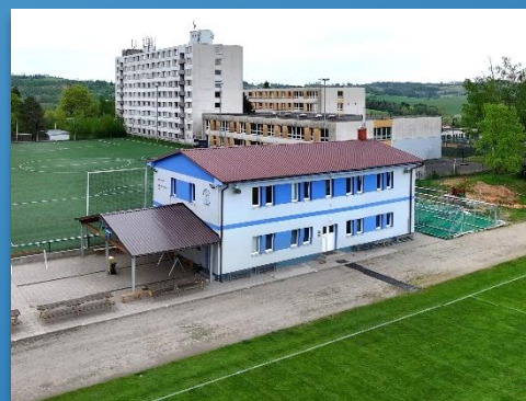
Výměna bojleru v hlavní budově / červenec 2025
