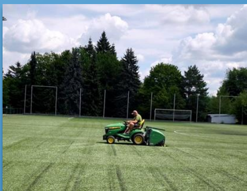
Oprava a údržba hřiště s umělou trávou / červenec 2025
